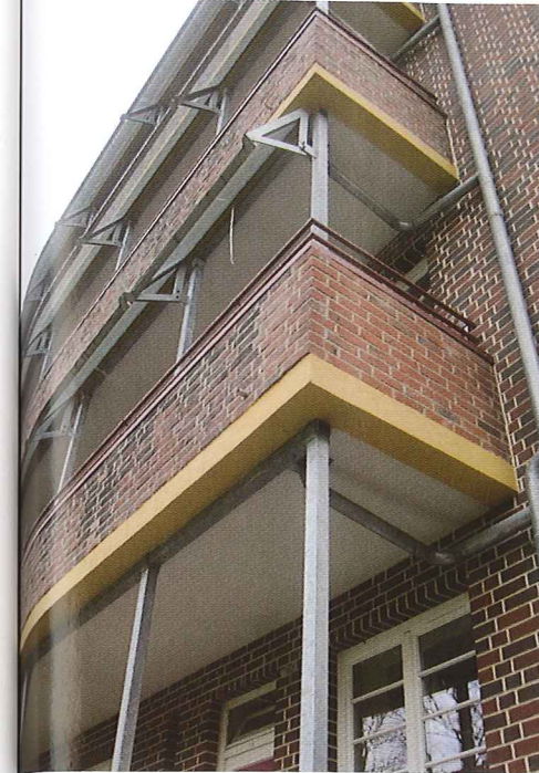
Teräksiset tuet eivät vastaa alkuperäistä rakennustapaa vuodelta 1929
