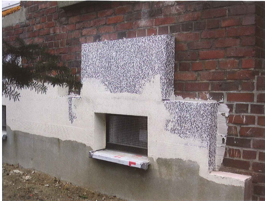
Dulsburgin kaupunginosassa kokeillaan korjaamista lisäämällä eristekerros vanhan julkisivun päälle.
