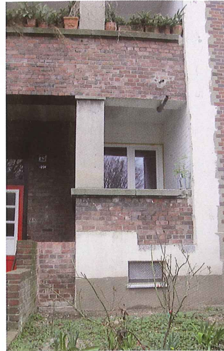
Eristeen päälle kiinnitetään levyt, jotka saavat tiilmäisen ulkonäön tiilimurskeesta.
